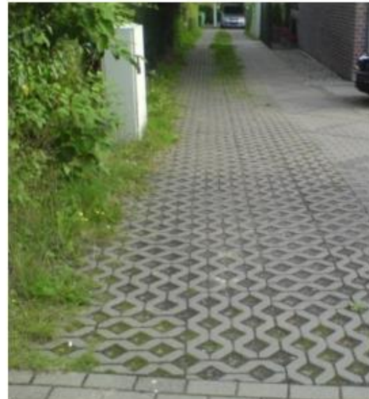
Figur 6-2. Exempelbilder för utformning av genomsläpplig beläggning (Uppsala Vatten)
