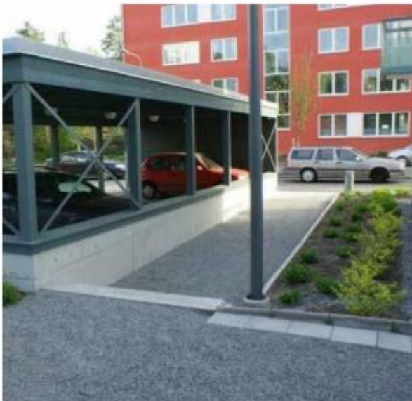
Figur 6-2. Exempelbilder för utformning av genomsläpplig beläggning (Uppsala Vatten)
